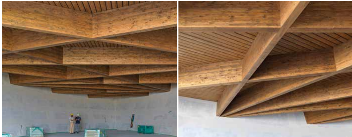
Oratorium. Außenwände, Überdachung mit tragender Struktur aus Brettschichtholz
