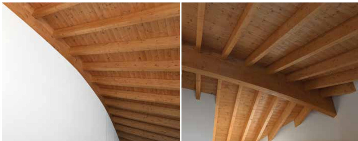
Villa C. Dachkonstruktion
