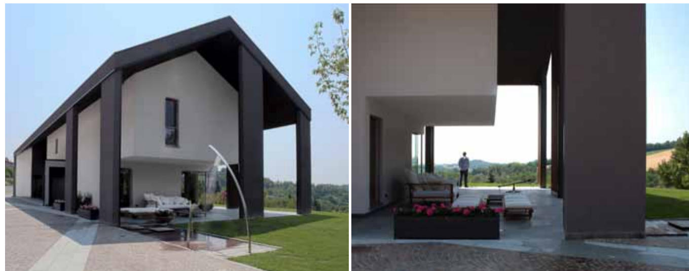
Villa SSM. Standort San Salvatore Monferrato, AL Planer Arch. Diego Bortolato Baujahr 2012
